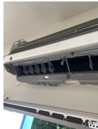
15.エアコンクリーニング
