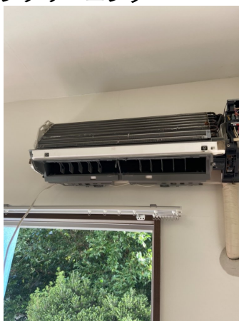
15.エアコンクリーニング
