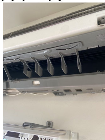
15.エアコンクリーニング
