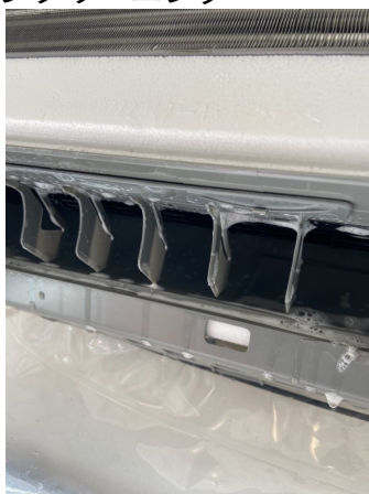
15.エアコンクリーニング
