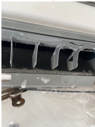
15.エアコンクリーニング
